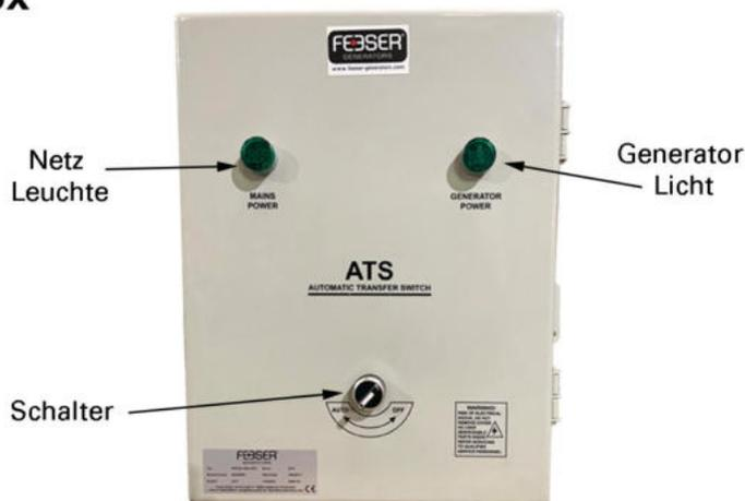
Die ATS Box dient zur automatischen Start des Generators bei Netzausfall.
