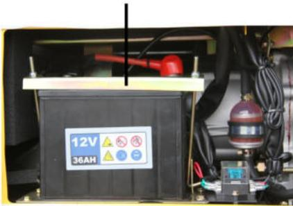
Prüfen Sie den Stand des Elektrolyts in der Batterie einmal monatlich. Wenn der Flüssigkeitsstand unterhalb der unteren Markierung liegt, füllen Sie mit destilliertem Wasser bis zur oberen Markierung auf.
